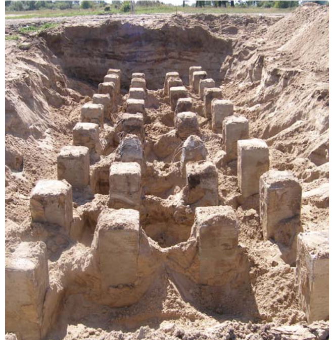
Fot. 5. Fundament palowy filara mostu M-1 przez Wartę w ciągu obwodnicy Gorzowa
