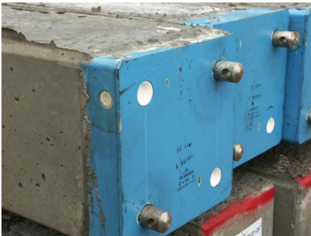
Fot. 4. Typowa złączka pala prefabrykowanego
