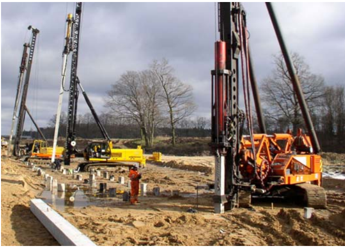
Fot. 3. Palownice w trakcie wykonywania wzmocnienia podłoża pod nasyp autostrady
