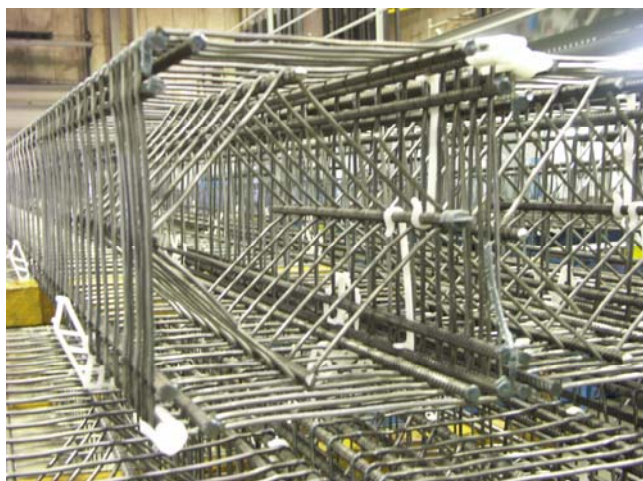
Fot. 1. Przykładowe zbrojenie pala
