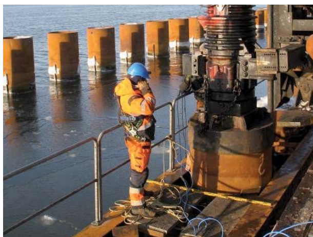
Rys. 5. Badanie pala rurowego (Terminal LNG w Świnoujściu)
